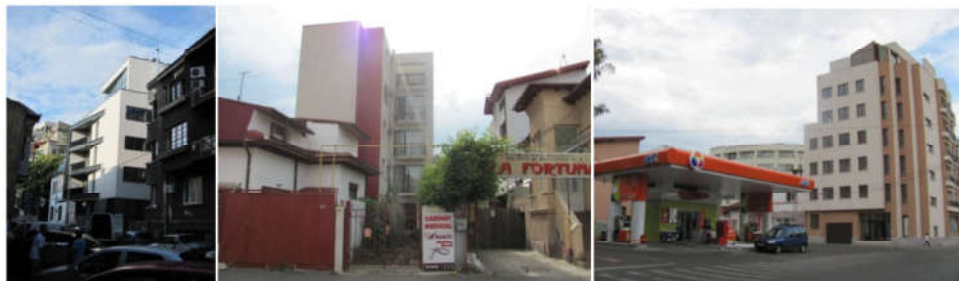
Figura 1. Blocuri noi de apartamente pe Vasile Lascăr 4
