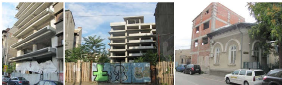
Figura 2. Blocuri în construcție pe Vasile Lascăr, abandonate de mulți ani
