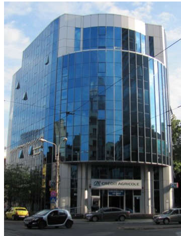
Figura 4. Clădirea ASIROM SA
